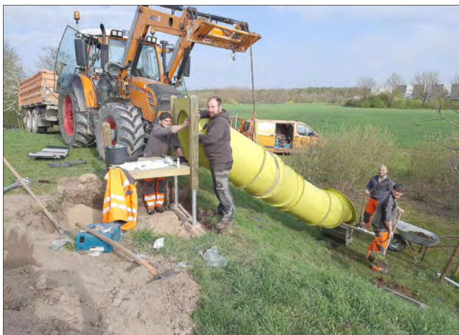
Der Bauhof installiert eine neue Tunnelrutsche am Hang der Freizeitfläche zwischen Heßdorf und Untermembach. Foto: Monika Voigt/VG Heßdorf
